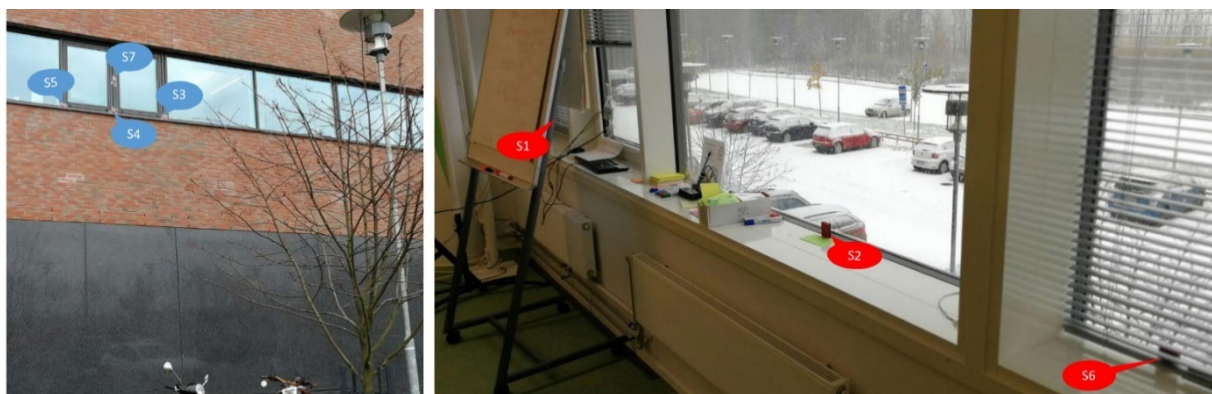
Figuur 23: Sensoren in een bedrijfspand die koppeling maken naar digital twin (Khajavi, 2019)
